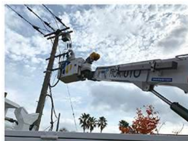
【高圧低圧電気設備工事】
