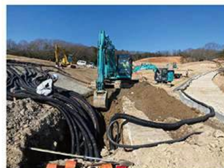
【電気土木工事】
