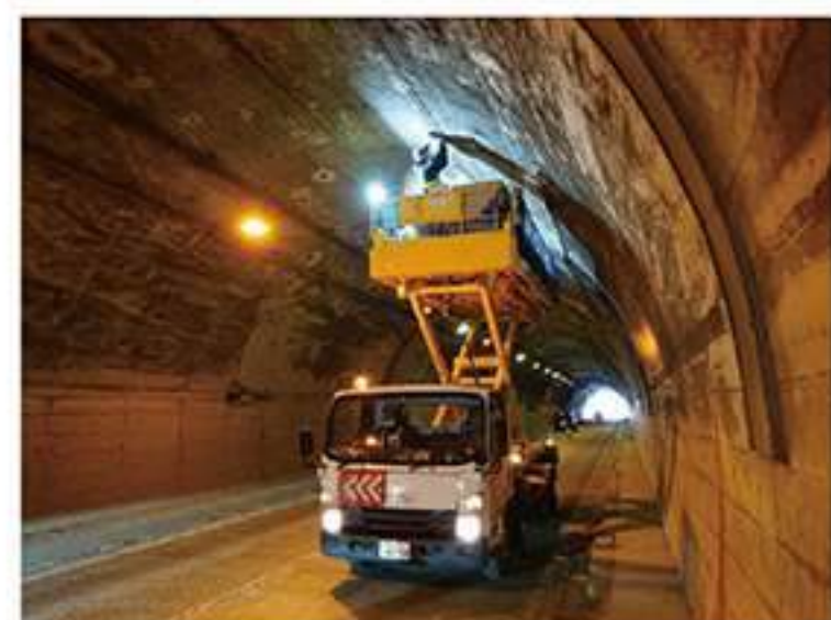
【トンネル照明灯設備工事】
