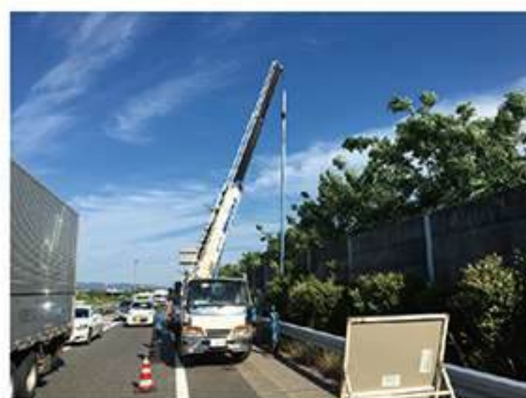
【道路照明灯設備工事】
