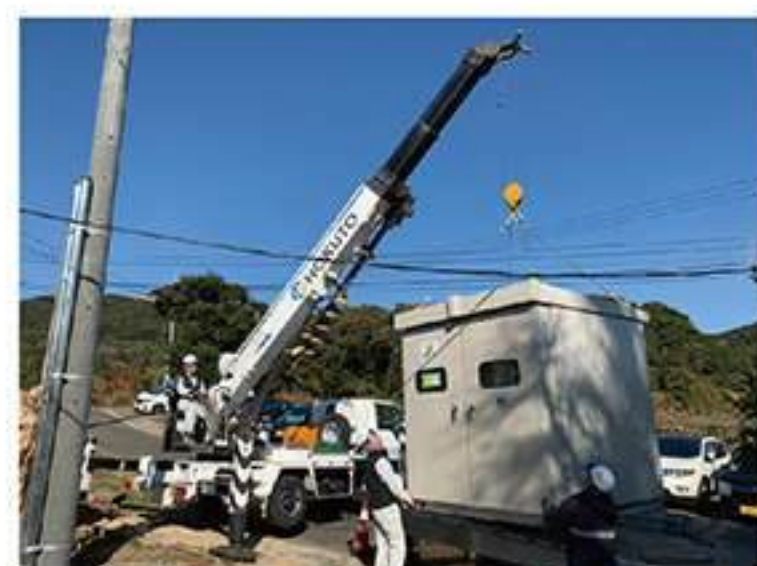
【高圧低圧電気設備工事】
