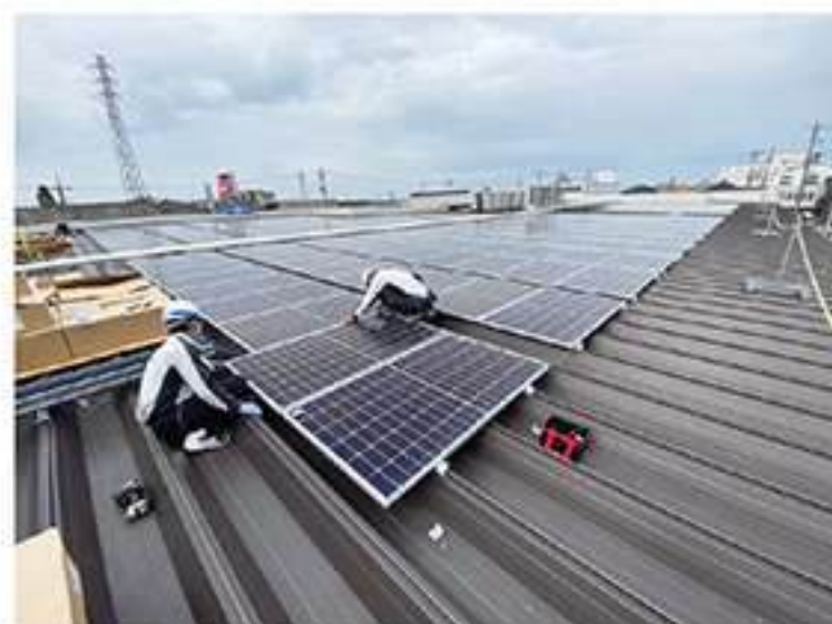
【太陽光発電設備工事】
