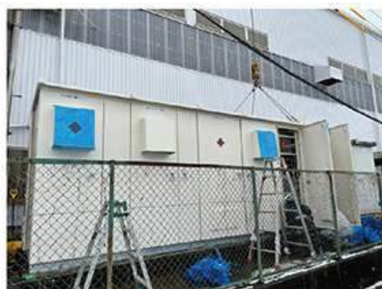
【高圧低圧電気設備工事】
