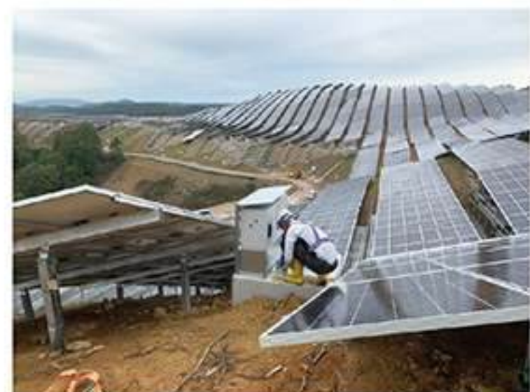
【太陽光発電設備工事】
