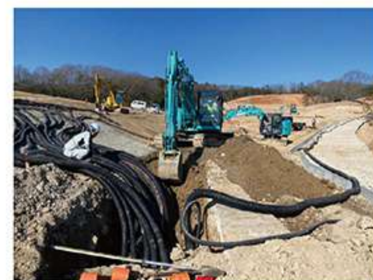
【電気土木工事】
