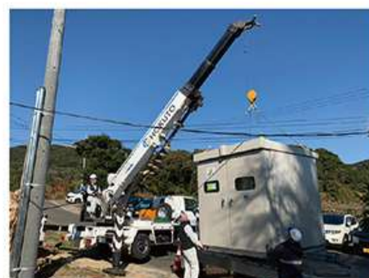
【高圧低圧電気設備工事】
