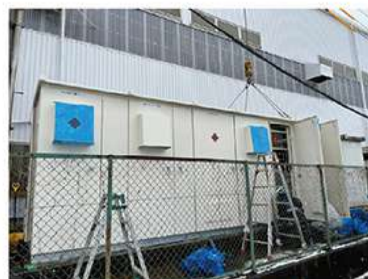
【高圧低圧電気設備工事】
