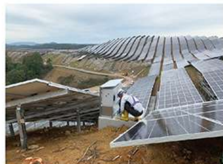
【太陽光発電設備工事】
