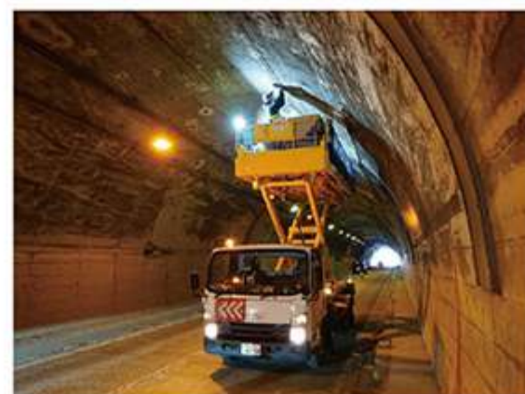
【トンネル照明灯設備工事】
