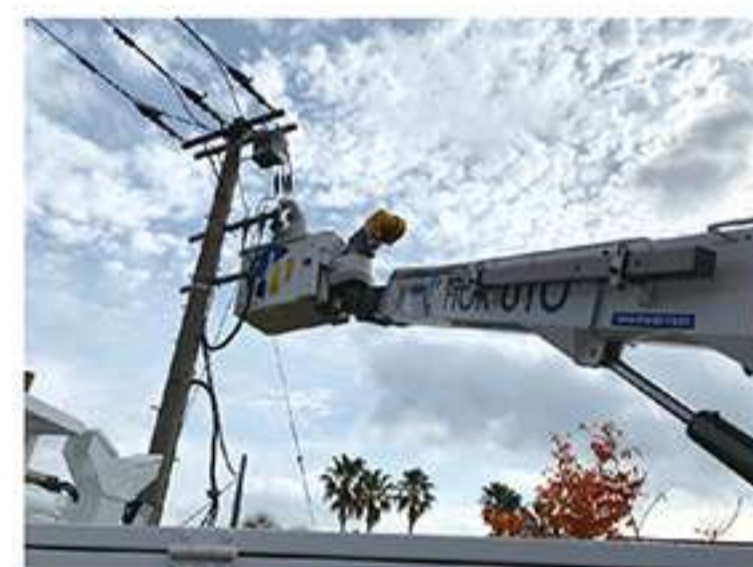
【高圧低圧電気設備工事】
