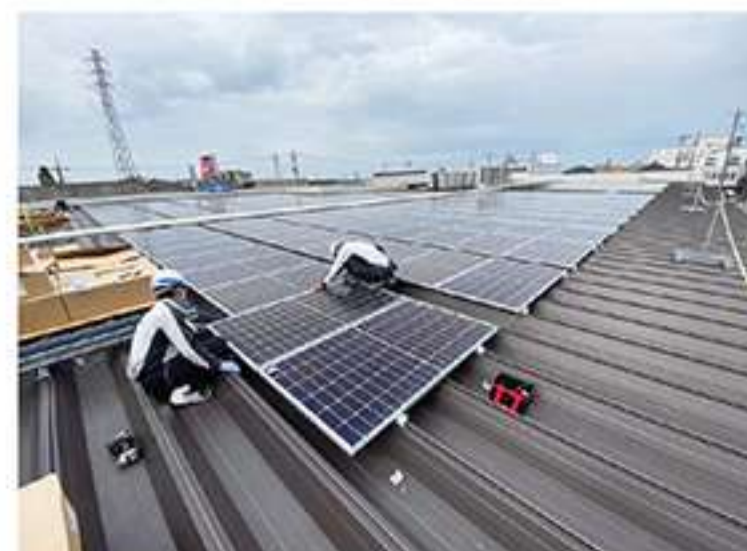
【太陽光発電設備工事】
