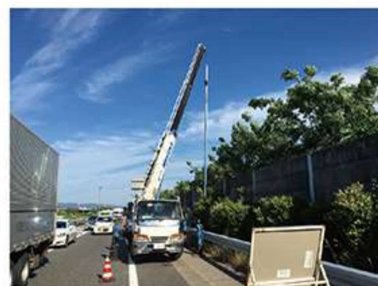
【道路照明灯設備工事】
